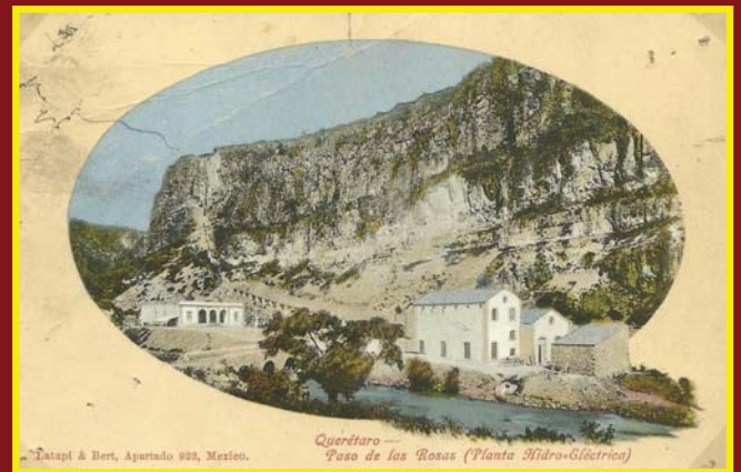
Planta Hidroeléctrica de Paso de las Rosas, Querétaro.
